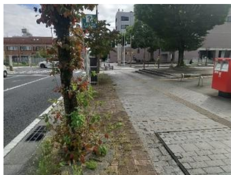
写真 6-4 インターロッキングブロック舗装上の雑草発生状況
