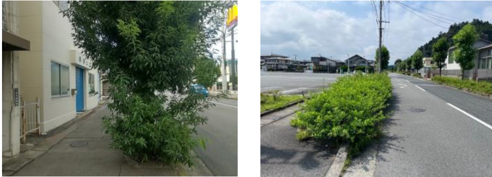
写真 4-7 枝葉の張り出しが通行の支障となっている状況
