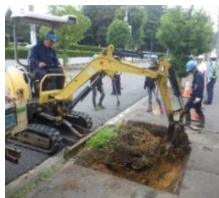
写真 4-6 空き植樹枿解消工事の状況
