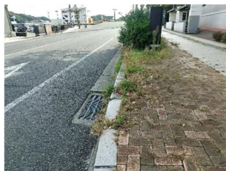
写真 6-4 インターロッキングブロック舗装上の雑草発生状況
