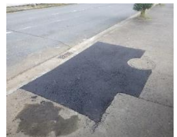
写真 4-6 空き植樹枿解消工事の状況
