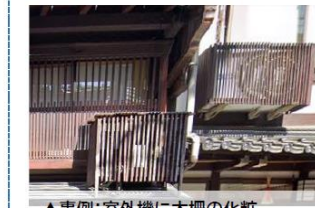
▲事例: 室外機に木柵の化粧
