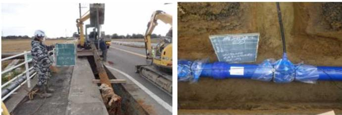
老朽管を撤去し新たな管を布設している様子
