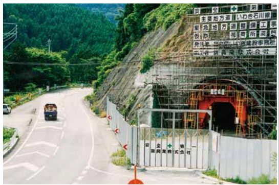
■写真2 新しい「御斎所洞門」の掘削工事 写真左がこれまでの道路。 [平成12(2000)年8月 板津弥吉氏撮影]
