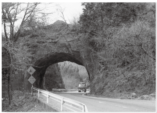
■写真1 「御斎所洞門」 [昭和51(1976)年3月 いわき市撮影]
