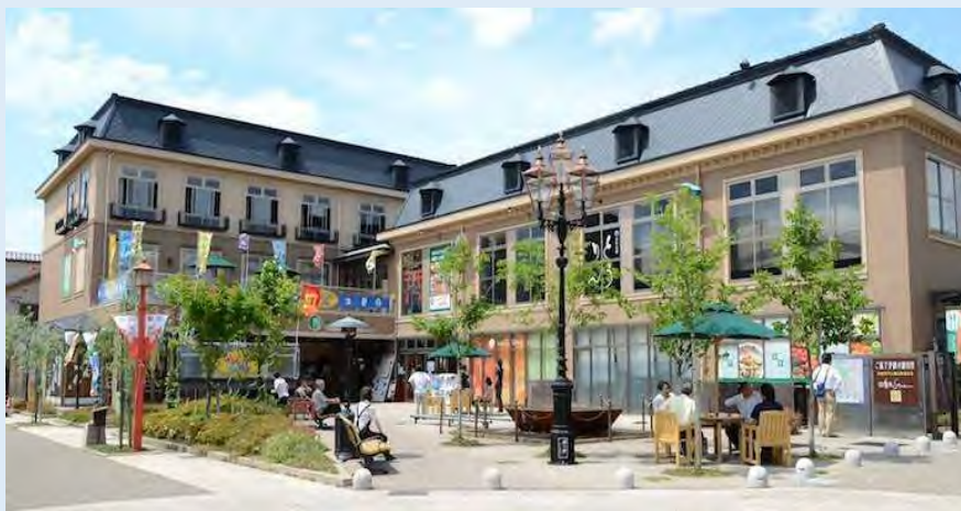
▲集約換地により整備された商業施設
