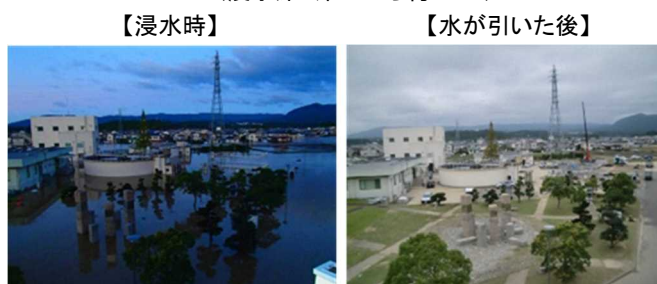
濃縮槽、脱水機棟、排水池(浸水深 地盤から約125cm)
