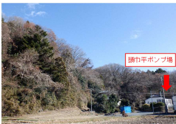
図 頭巾平ポンプ場 現地調査写真
