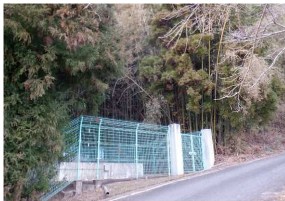
図 下ヶ屋敷調整池 現地調査写真
