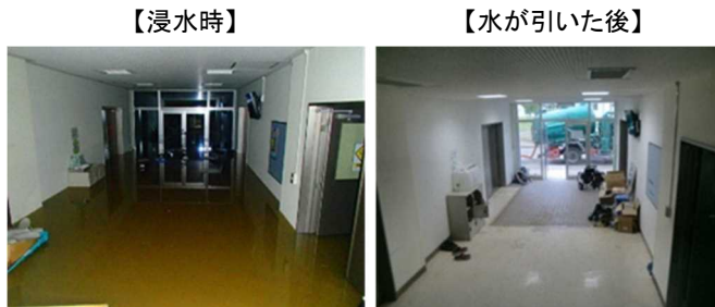
管理棟(電気室・ポンプ室・薬品注入室入口) (浸水深 床上から約62cm)
