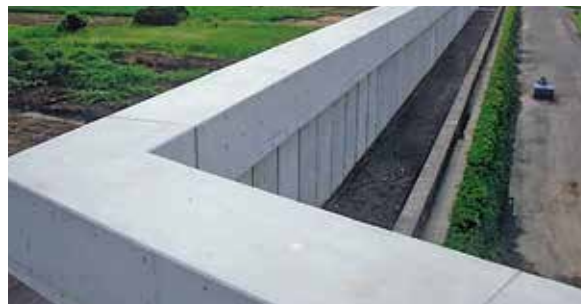
図76 津波・浸水対策のイメージ①(防護壁の設置)
