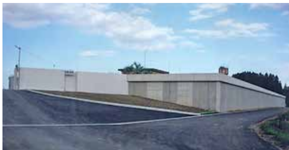
図76 津波・浸水対策のイメージ①(防護壁の設置)
