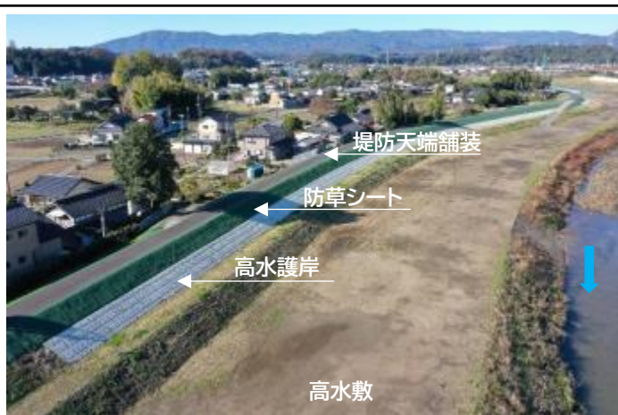
堤防天端舗装の施工状況
