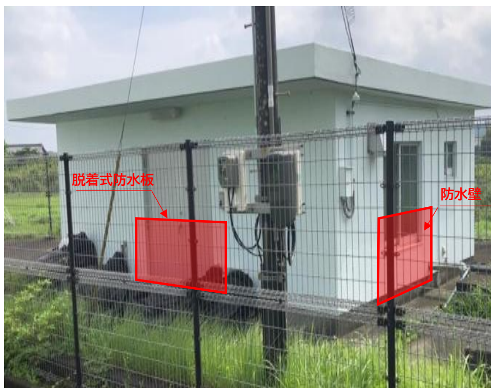
写真：平窪第2ポンプ
