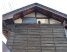
▲鎧張り羽目板の壁面
