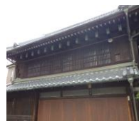
▲和瓦・木格子が 残された古建築
