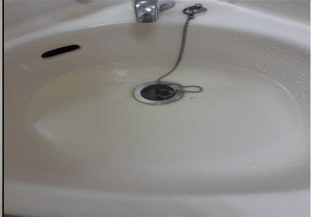
[状況] 水道管内の錆が水道水に出ていると見られ赤水が出る
