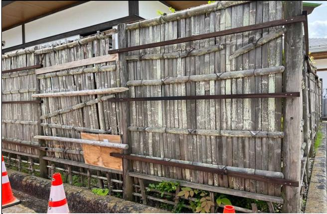
[状況] 竹製の目隠し柵が老朽化により破損
