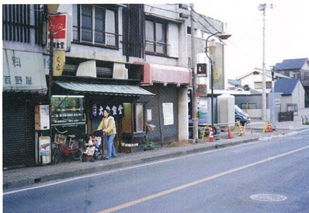
□従前の建物と八幡通り
