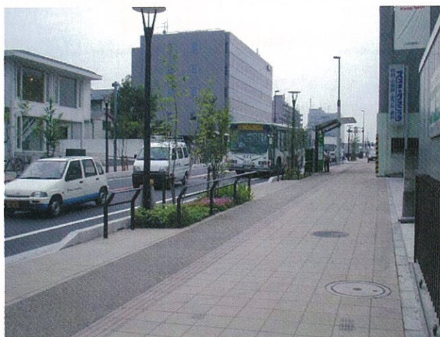
□整備された八幡通りとバス停車場
