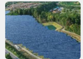
横峯・長井太陽光発電所 (東急不動産㈱)
