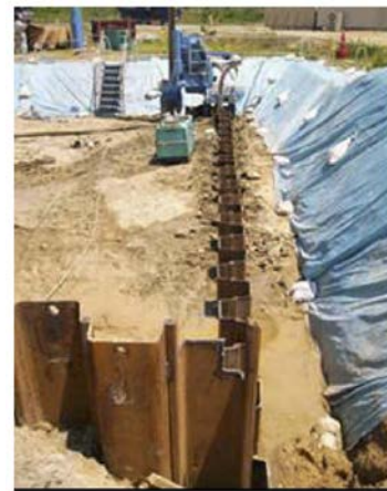
図 8-20 遮水壁（鋼矢板）の打設状況
