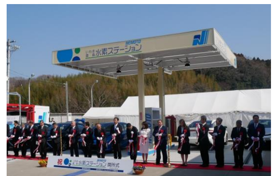
図 環境配慮型車両のための基盤整備 (水素ステーション)
