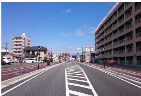
図 都市計画道路の整備（都市計画道路新川町谷川瀬線）
