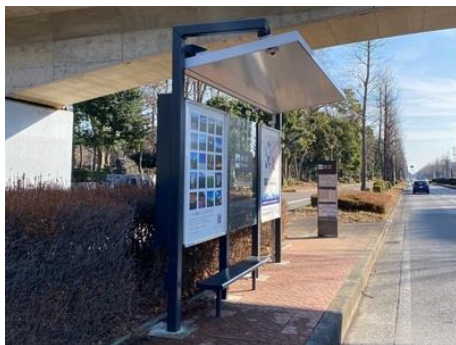
図 バス停留所の改善（上屋設置） 出典：つくば市
