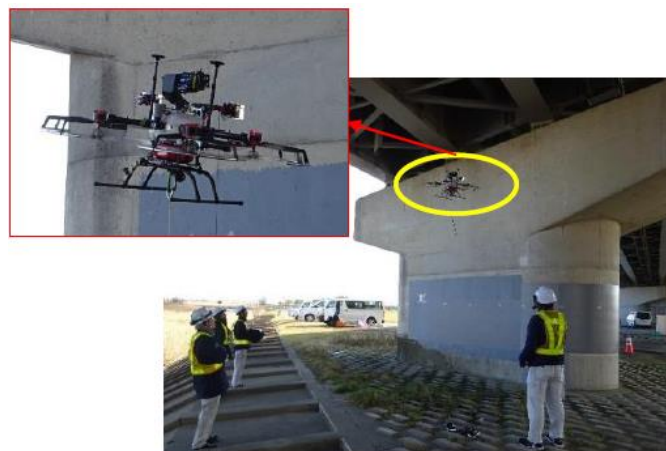
図 新技術を活用した橋梁点検（ドローンの活用）
