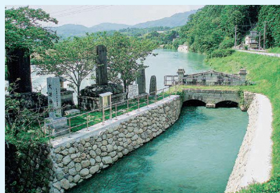
取水口(小川町関場)
