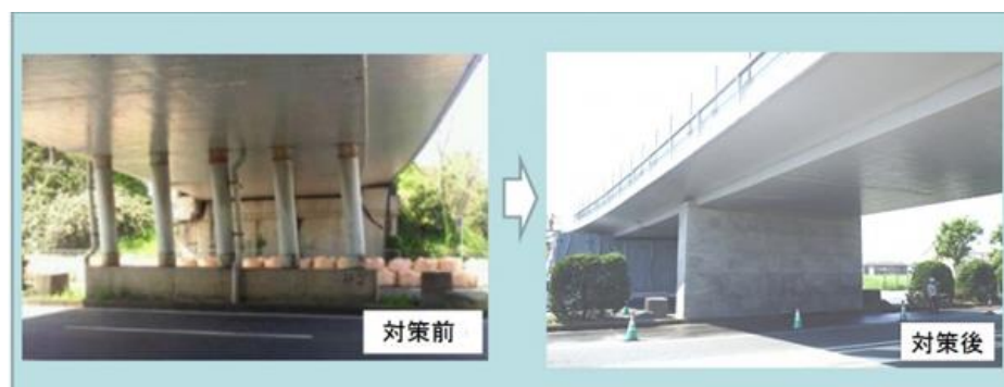
図 橋梁の耐震補強
