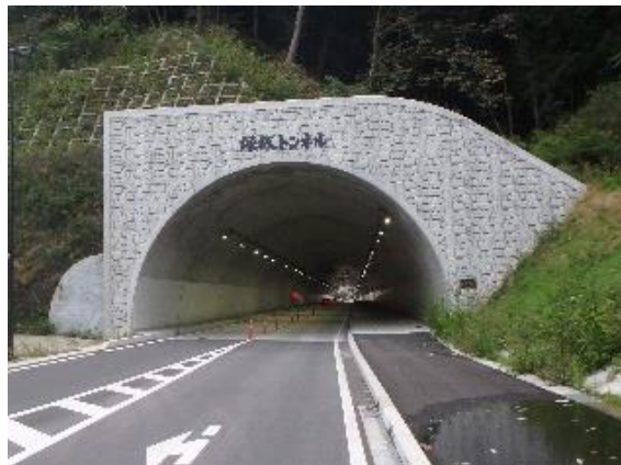
写真 掘坂トンネル
