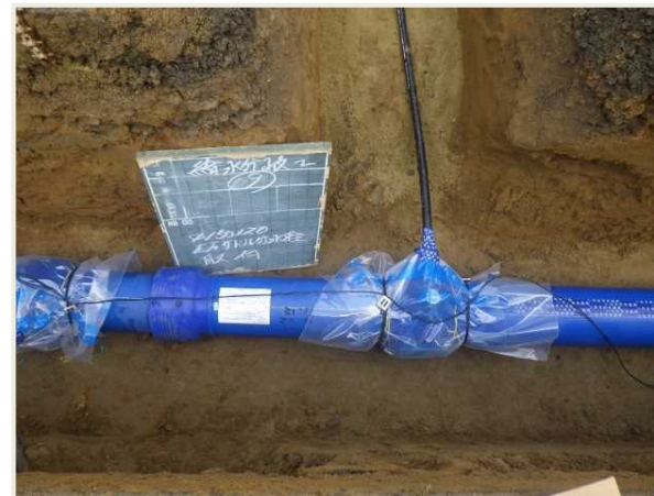
写真 耐震管布設の様子
