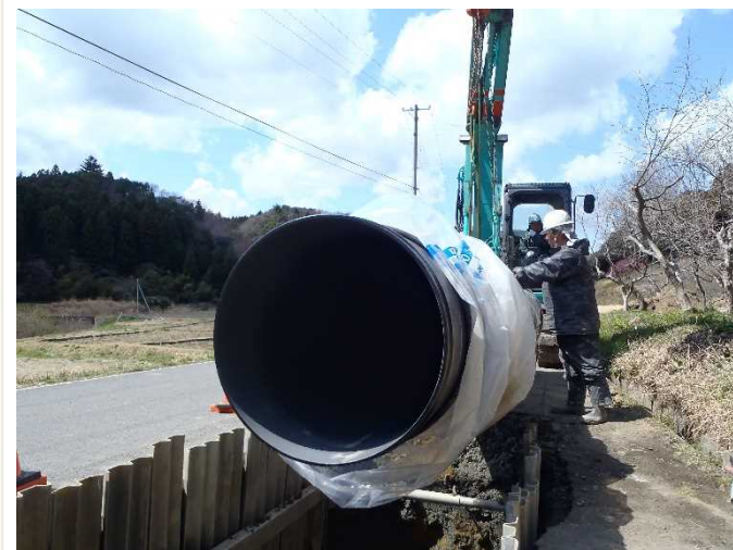
写真 φ800布設状況
