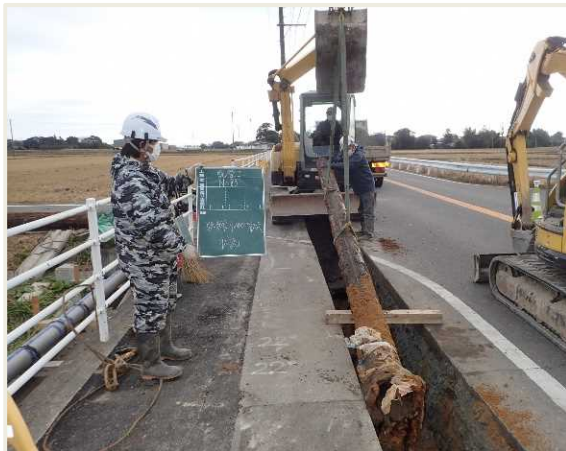
写真 老朽管更新の様子
