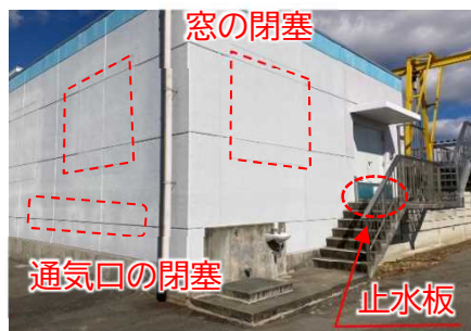
下平窪取水場 開口部閉塞対策後
