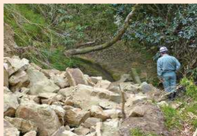
落石により大滝江筋用水路が閉塞(平成23年)
