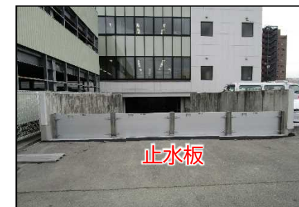
水道局本庁舎 止水板対策後
