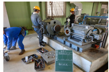
中央台ポンプ場 ポンプ設備の更新工事
