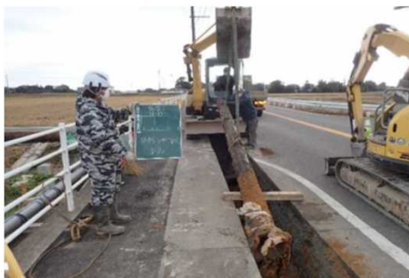
老朽管を撤去し新たな管を布設している様子
