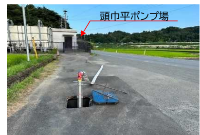
頭巾平ポンプ場 接続用配管の対策工事
