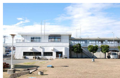
泉浄水場(昭和39年建設)
