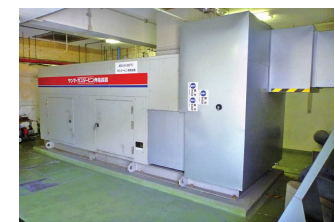
上野原浄水場の非常用自家発電設備
