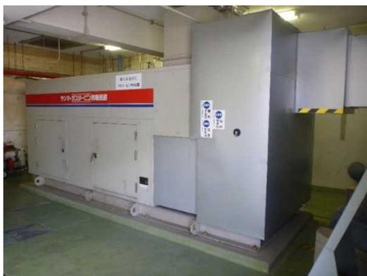
図 18 上野原浄水場の非常用自家発電設備
