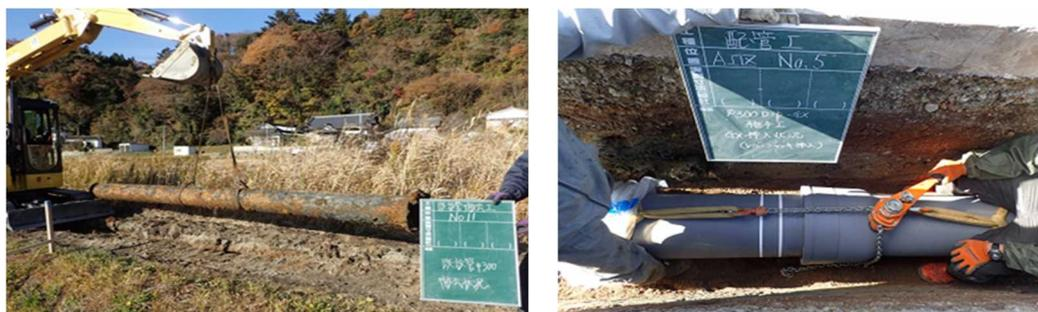
（左 老朽管の状況、右 耐震管布設の様子）
