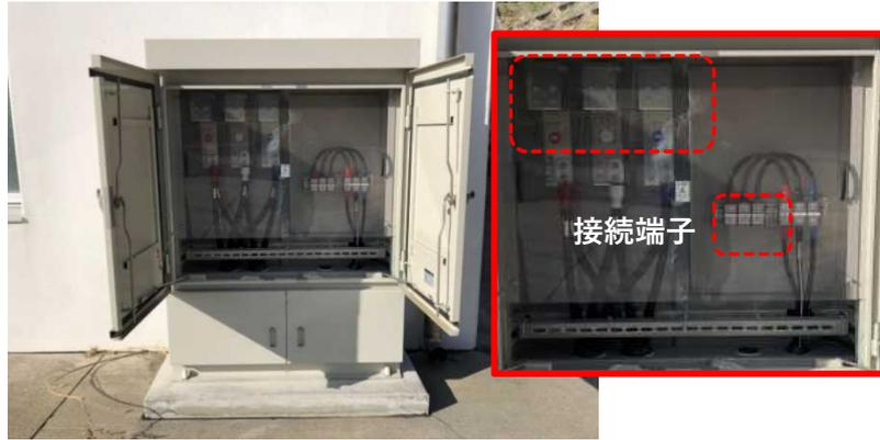
図 19 非常用発電機接続用端子盤
