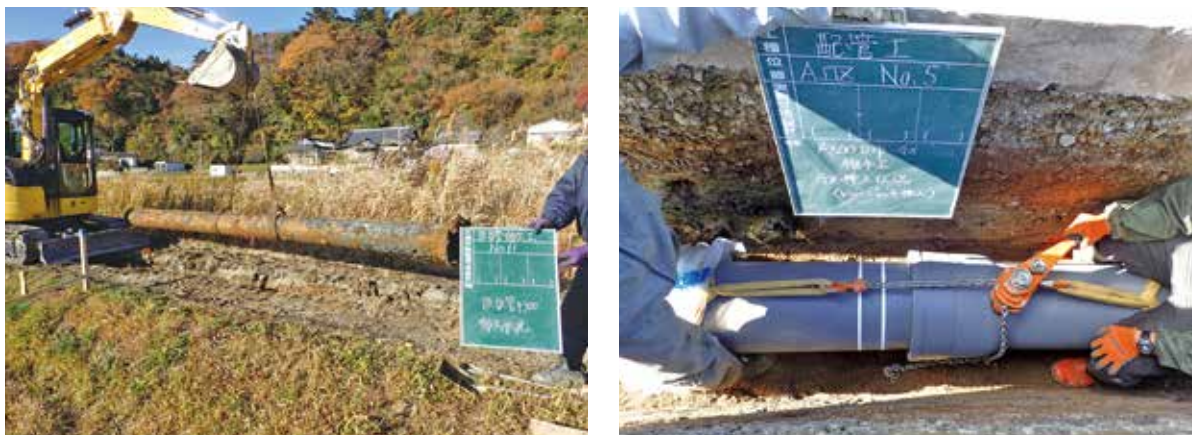
（左：老朽管の状況、右：耐震管布設の様子）
