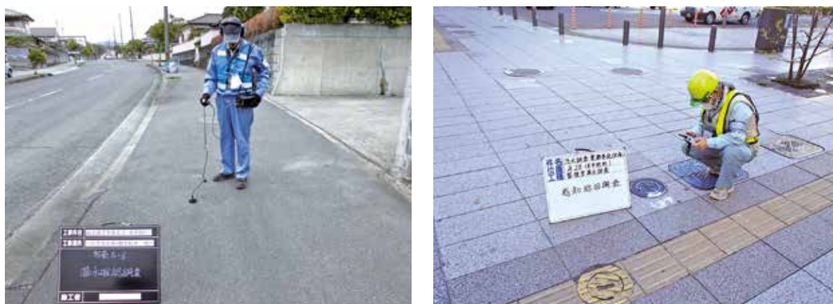
図81 漏水調査の様子(左：路面音聴調査 右：監視型漏水調査)
