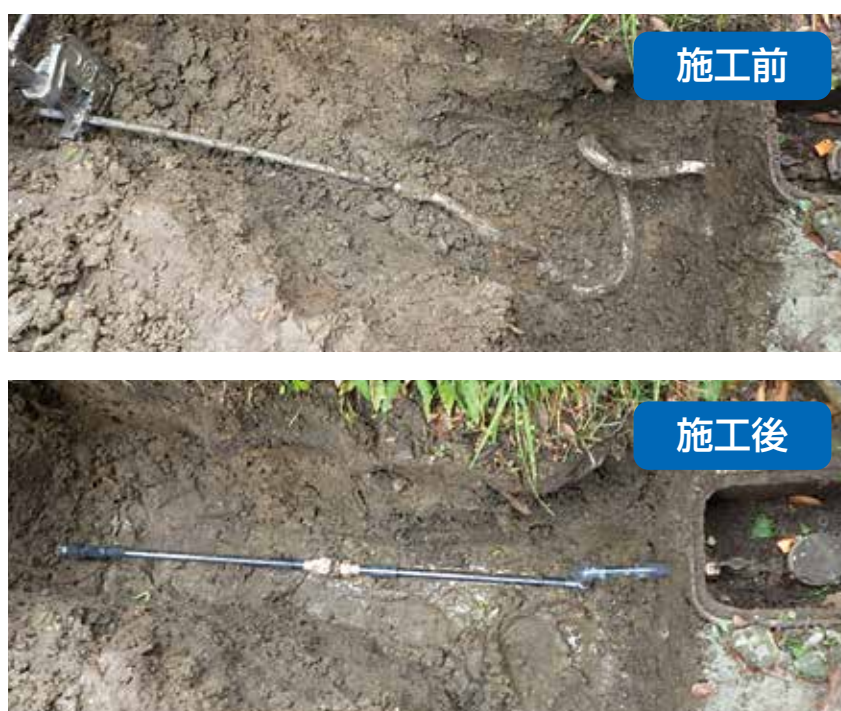
図 68 鉛製給水管の布設替えの状況
