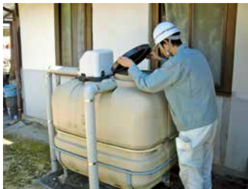
図 66 小規模貯水槽水道の点検の様子
