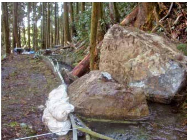
図 東日本大震災における大滝江筋用水路の被害状況
