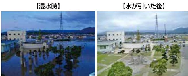
濃縮槽、脱水機棟、排水池(浸水深 地盤から約125cm)
