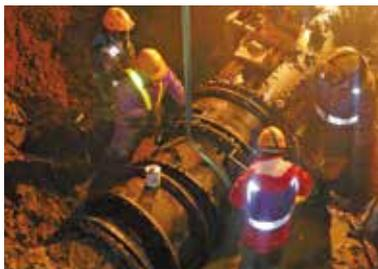
【山玉浄水場のφ800mm送水管の漏水修理】
