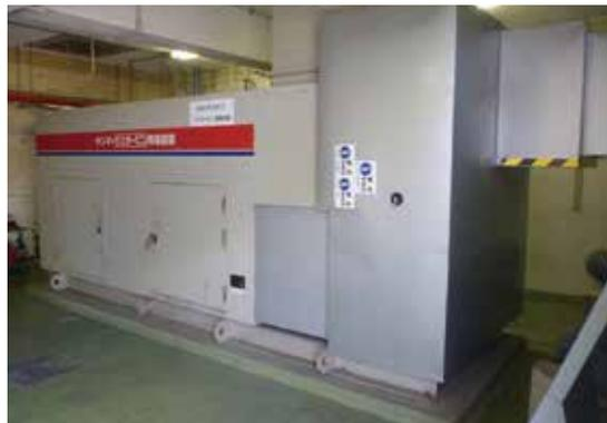
図35 上野原浄水場の非常用自家発電設備
