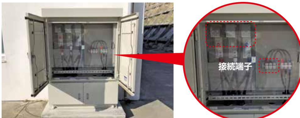
図36 非常用発電機接続用端子盤
