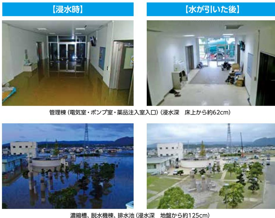
図28 平浄水場の浸水状況
