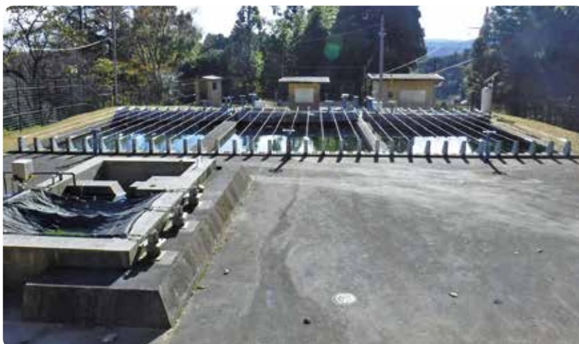
図16 鷹ノ巣浄水場
