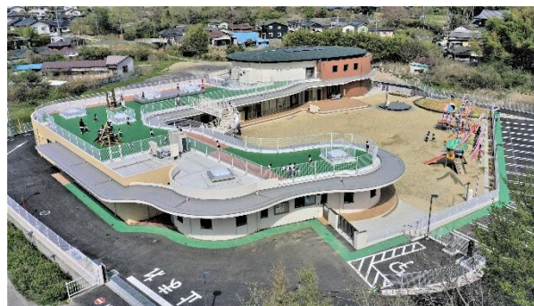
〈令和5年1月完成〉
