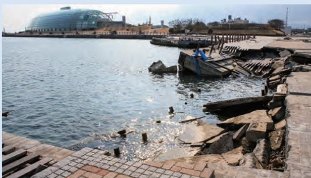
津波により破壊されたアクアマリンパークデッキ（平成23年3月25日 いわき市撮影）
