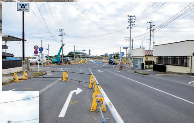
▲ 10-2 小名浜駅の移転後、臨港道路までの道路延長工事〔平成27(2015)年9月 いわき市撮影〕
