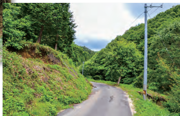
▶ 1-3 復旧工事が完了〔平成 24(2012) 年 6 月 いわきジャーナル撮影〕
