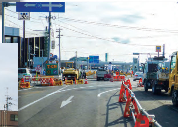
▲ 10-4 県道小名浜港線の交差点工事と建設中の「イオンモールいわき小名浜」〔平成30(2018)年1月 いわき明星大学震災アーカイブ室撮影〕
