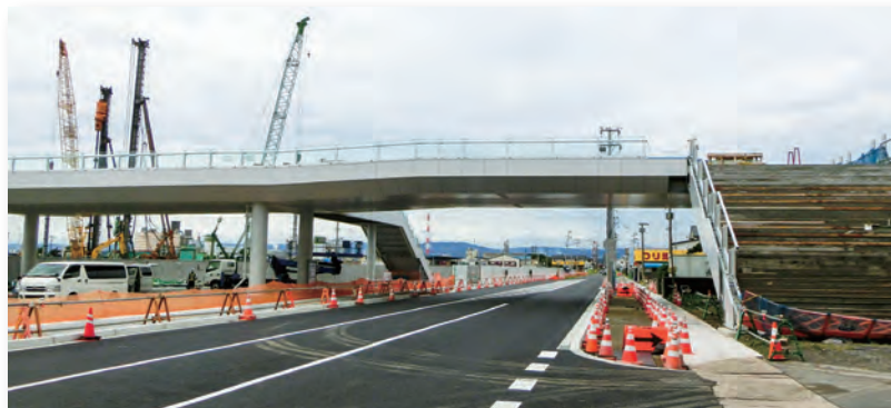
▲ 11-3 建設中の「イオンモールいわき小名浜」の 2 階と通じる横断歩道橋 〔平成 28(2016) 年 9 月 いわき市撮影〕
