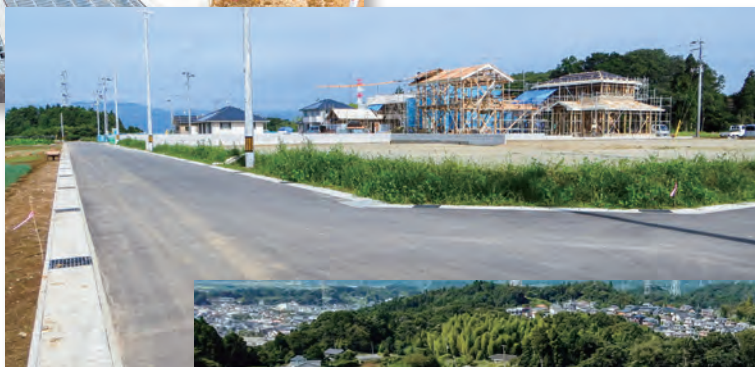
◀ 8-4 岩間震災復興土地区画整理事業区域に家屋が建設〔平成27(2015)年7月 いわき市撮影〕
