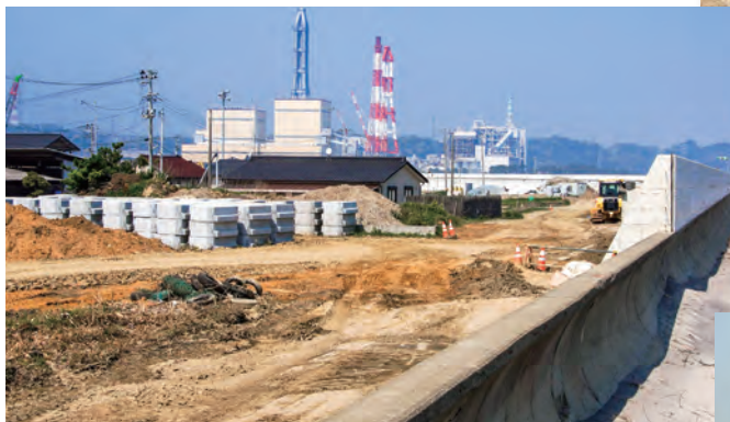
▲ 9-5 須賀海岸で防潮堤かさ上げ工事〔平成 27(2015) 年 4 月 いわきジャーナル撮影〕
