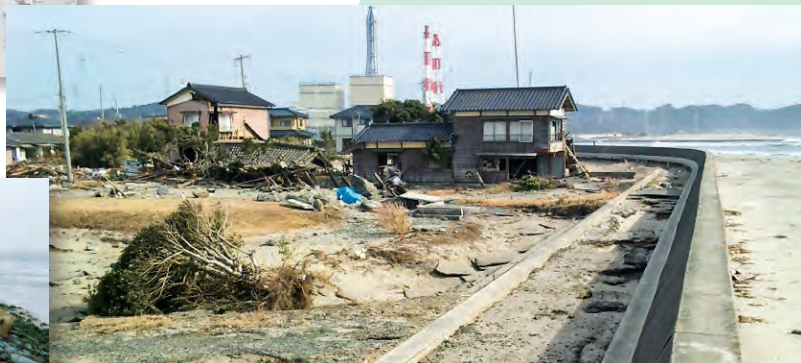
▼ 9-2 東日本大震災の大津波で被災した錦町須賀〔平成 23(2011) 年 3 月 19 日 いわき市撮影〕
