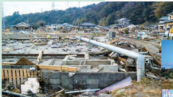
◀ 6-1 被災した岩間町岩下の集落〔平成 23(2011)年 3 月 14 日 いわき市撮影〕
