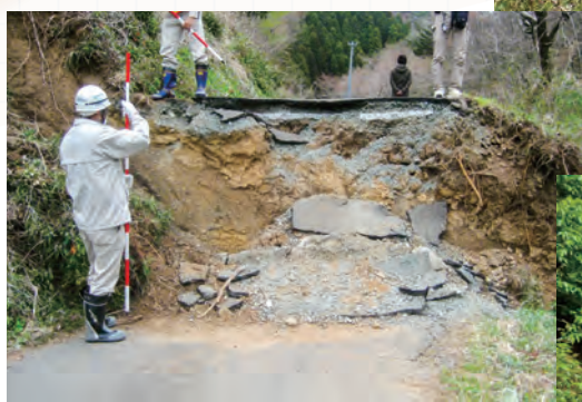
▶ 1-2 復旧工事〔平成 23(2011) 年 4 月 18 日 いわき市撮影〕
