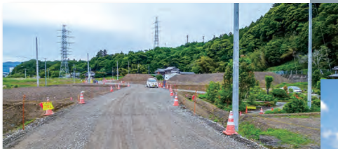
▲ 6-3 岩間町の山際にかさ上げて震災復興土地区画整理事業を施工〔平成 27(2015)年 6 月 いわき市撮影〕
