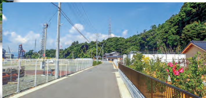
▼ 6-4 岩間震災復興土地区画整理事業が完成して進む宅地化〔平成 30(2018)年 8 月 いわき市撮影〕
