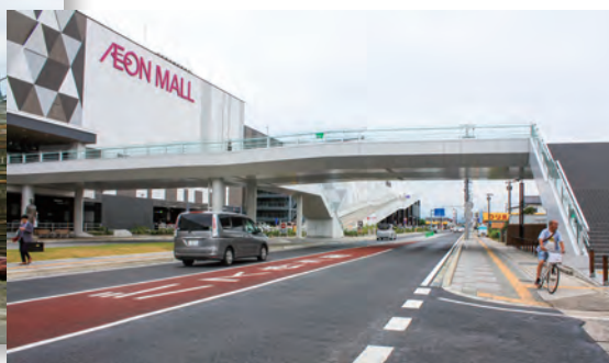
▲ 11-4 「イオンモールいわき小名浜」と整備された県道 〔令和元 (2019) 年 8 月 医療創生大学震災アーカイブ室撮影〕
