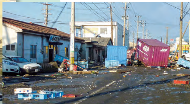
▲ 11-2 東日本大震災の大津波で被災した県道小名浜港線の沿道② 11-1 の少し東側に移動した位置。〔平成 23(2011) 年 3 月 12 日午前 7 時 佐川紘一氏撮影〕
