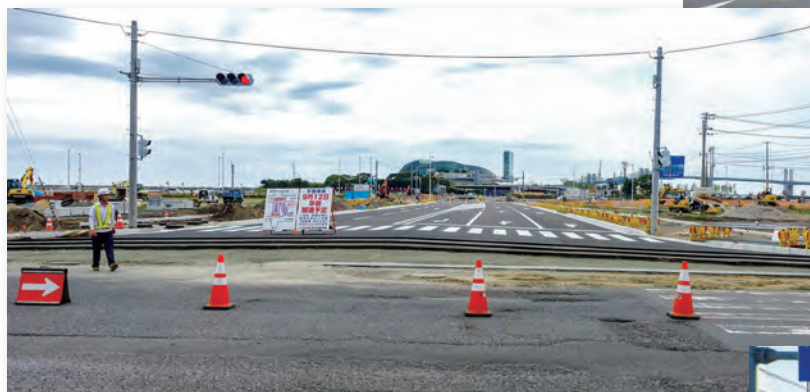
▲ 10-3 臨港道路までの道路延長工事〔平成29(2017)年9月 いわき市撮影〕
