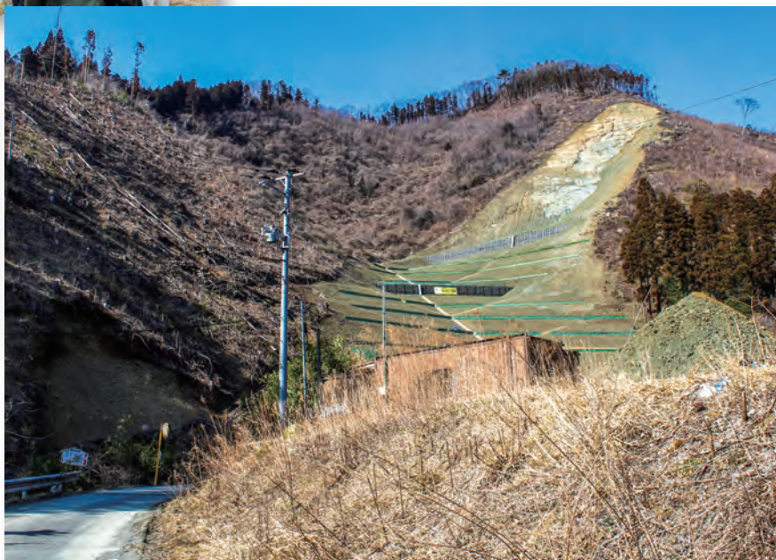
▶ 3-5 地すべりの復旧工事が完了〔平成25(2013)年3月 いわきジャーナル撮影〕
