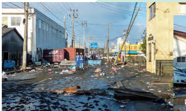
▲ 11-1 東日本大震災の大津波で被災した県道小名浜港線の沿道① 西方に向かって見る。写真左が福島臨海鉄道小名浜駅。〔平成 23(2011) 年 3 月 12 日午前 7 時 佐川紘一氏撮影〕
