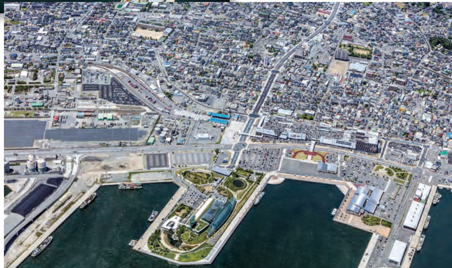
7-7 小名浜駅の跡地にイオンモールいわき小名浜、その東側に国や県の合同庁舎が完成〔平成 30(2018)年 6 月 いわき市撮影〕
