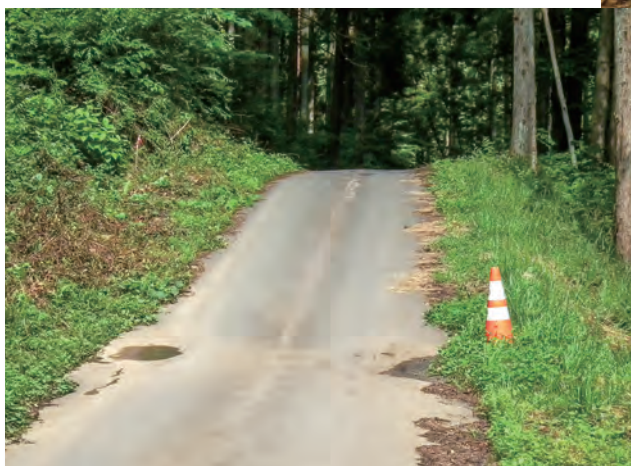
▶ 2-2 復旧工事が完了〔平成 26(2014) 年 7 月 いわき市撮影〕
