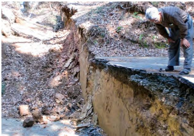
■ 写真3-20 誘発地震で塩ノ平断層付近の市道が高さ2mのずれ [平成23(2011)年4月13日 いわき市撮影]
