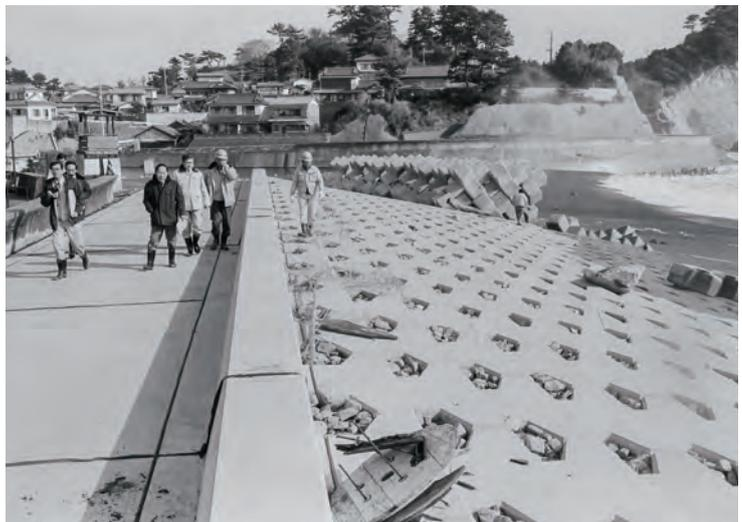
■写真 3-18 高潮を防ぐため、久之浜海岸においては、海岸沖に設けられた消波堤に加え、緩傾斜堤、堰堤を設置（平成 3(1991)年 2 月 いわき市撮影）
