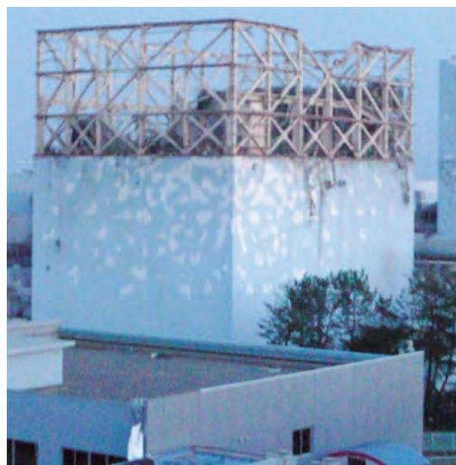
■写真3-25 内部が溶け出して破損した1号機〔平成23(2011)年3月12日 東京電力(株)提供〕
