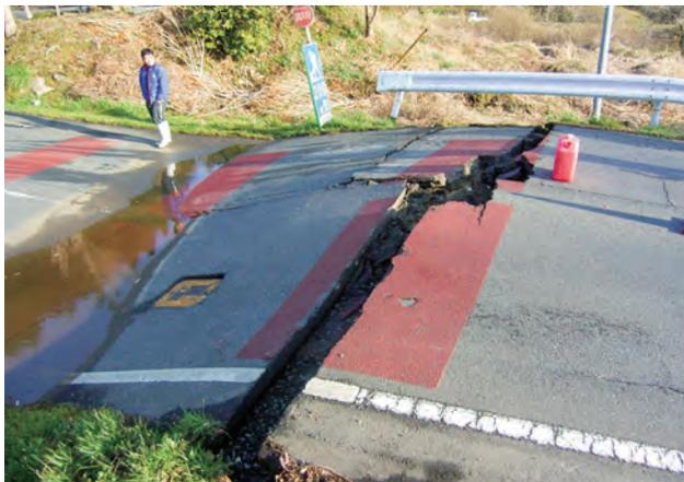
■ 写真3-21 田人町黒田字台の断層上に位置していた県道皿貝・勿来停車場線の被害 [平成23(2011)年4月12日 県いわき建設事務所撮影]
