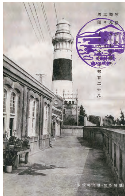
■写真 2-6 ツートン柄の外壁が剥落した塩屋埼灯台 修理に際し、白亜の灯台となった。〔昭和10年代 郵便絵はがき〕
