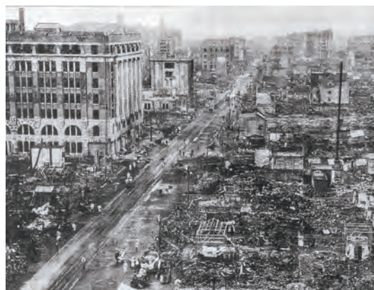
■写真 2-4 関東大震災で全壊した日本橋通りの中心部〔大正12(1923)年9月 郵便絵はがき〕
