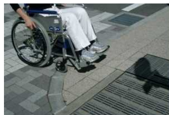
歩車道の段差解消
