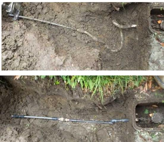
鉛製給水管の布設替えの状況
