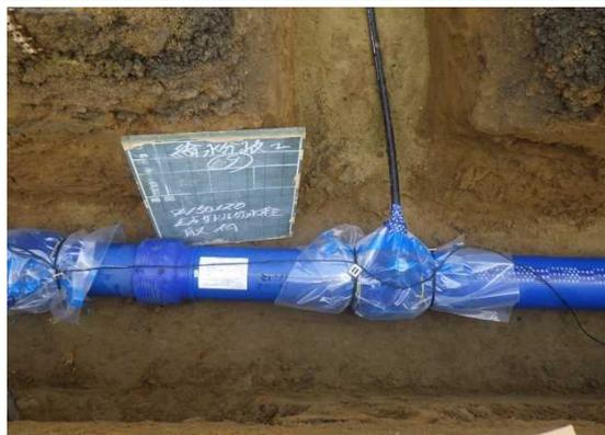
耐震管布設の様子(水道配水用ポリエチレン管)
