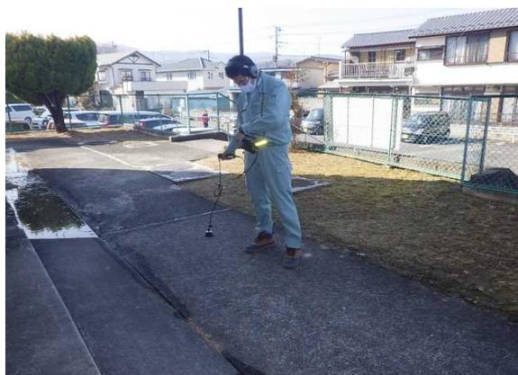
漏水調査の様子①（路面音聴調査）
