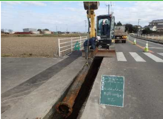
老朽管更新の様子
