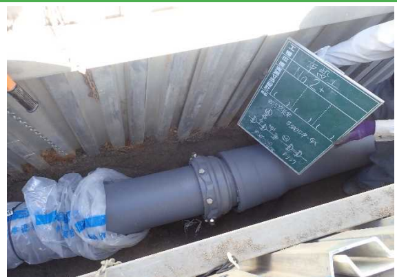
耐震管布設の様子
