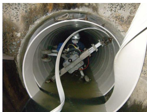
図 5-4 管更正*の工事現場写真
