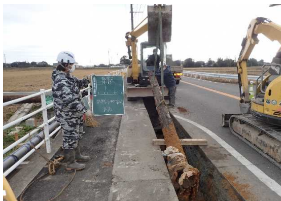
老朽管更新の様子
