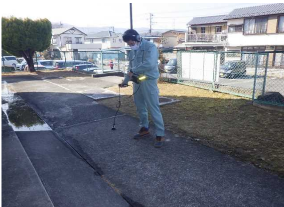
漏水調査の様子①（路面音聴調査）
