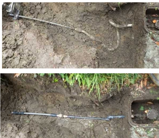
鉛製給水管の布設替えの状況
