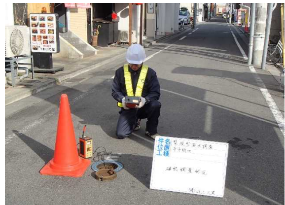
漏水調査の様子②（管路音圧監視システム）
