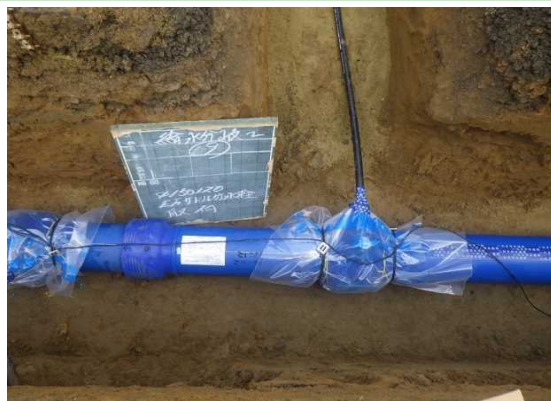
耐震管布設の様子(水道配水用ポリエチレン管)
