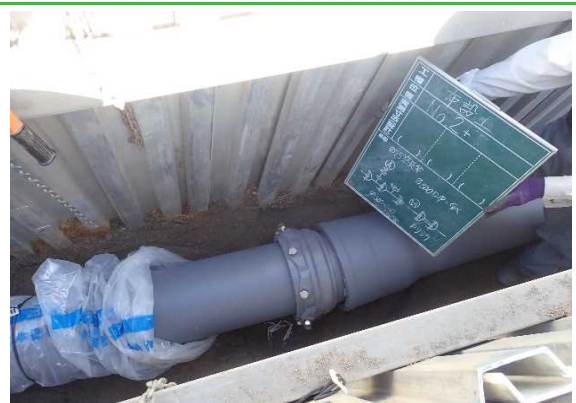
耐震管布設の様子
