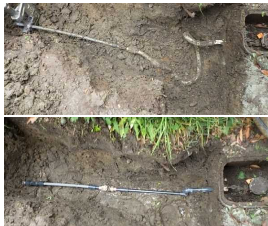
鉛製給水管の布設替えの状況 上：施工前 下：施工後
