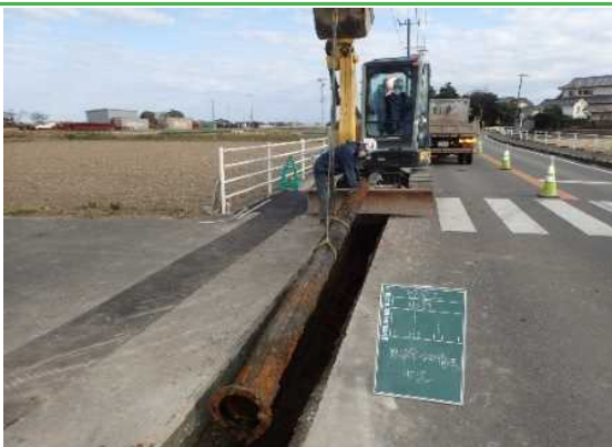
老朽管更新の様子
