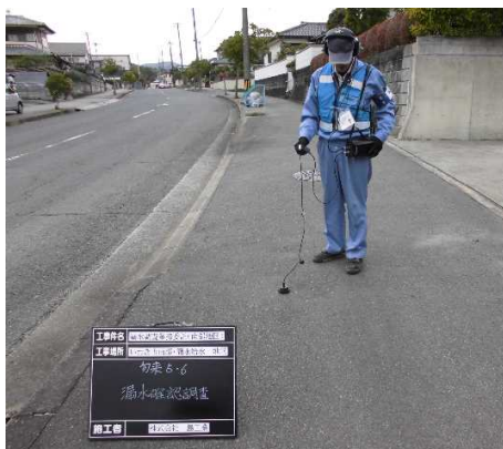
漏水調査の様子①（路面音聴調査）
