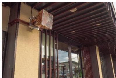
（音響機器の設置）
