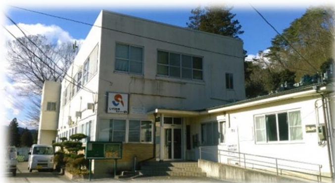
いわき市川前支所
