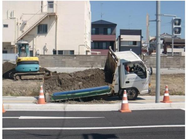
写真 老朽化した管きよによる陥没事故の状況
