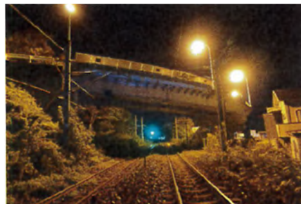
跨線橋（JR 線路上の橋梁）
