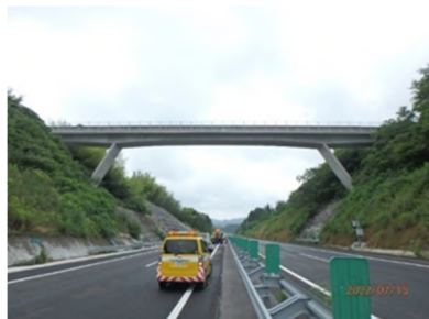
跨道橋（高速道路上の橋梁）
