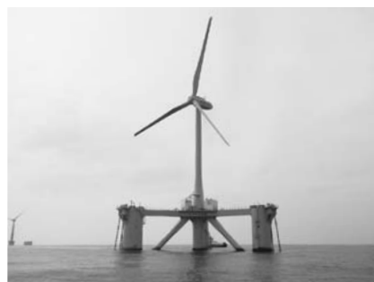
浮体式洋上風力発電の実証研究
