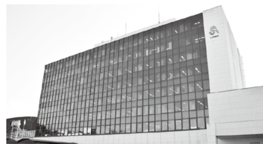
本庁舎などの耐震化改修に向け基本設計を実施
