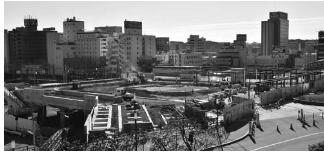
3月に供用開始予定のいわき駅北口交通広場
