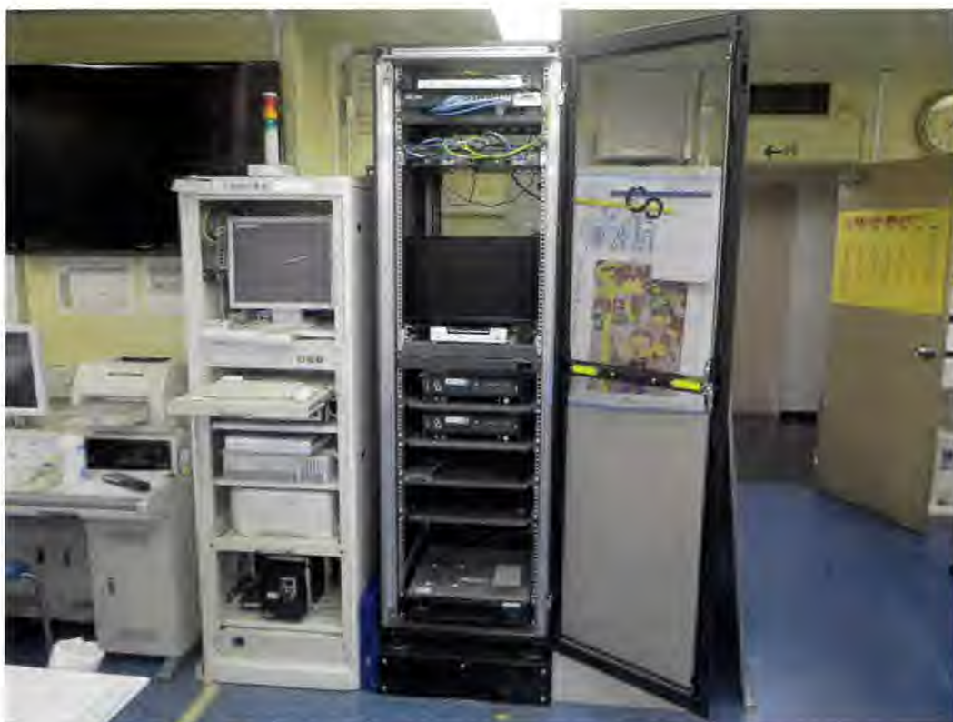
位置：いわき市役所 危機管理室 内容：着手前
