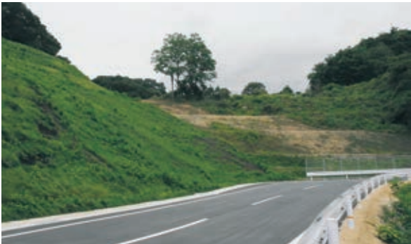
写真5-6 内郷内町地内の市道宮沢－蛭内線（復旧後） 平成24(2012)年4月に通行が可能となった。 〔いわき市撮影〕
