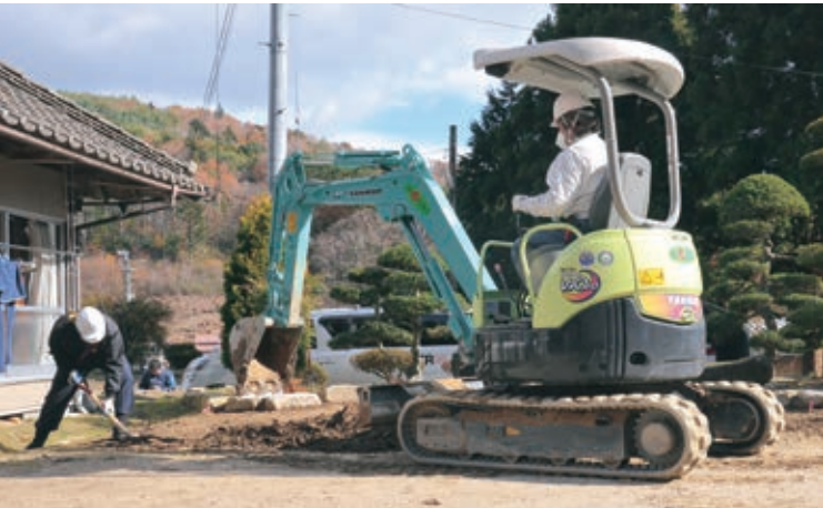
写真5-18 川前町民家の除染作業 〔平成24(2012)年11月 いわき市撮影〕
