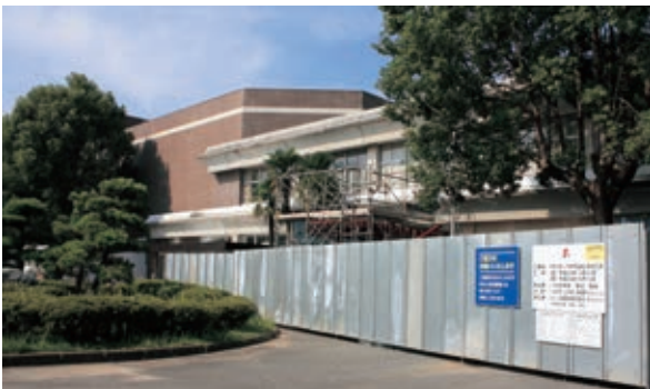
写真5-4 勿来、常磐の市民会館は計画より1年前倒して平成24年10月に常磐、同年11月に勿来のホールがそれぞれ再開工事中の勿来市民会館。 〔平成24(2012)年10月 いわき市撮影〕
