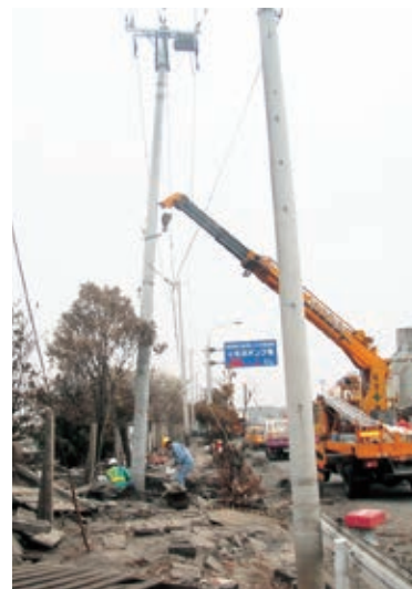
写真4-44 復旧工事を急ぐ（小名浜） 〔3月 東北電力㈱提供〕
