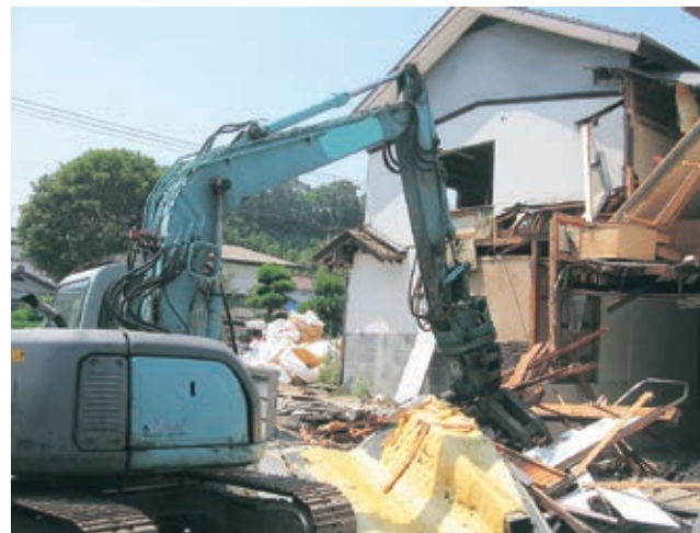
写真4-85 被災した家屋を解体撤去 〔7月15日 いわき市撮影〕
