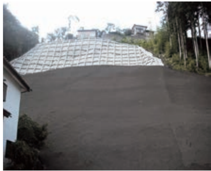
写真4-88 「県災害関連緊急急傾斜地崩壊対策事業」で施工した駒谷地内 〔福島県いわき建設事務所提供〕
