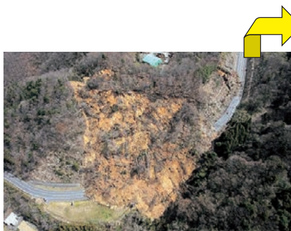
写真4-58 主要地方道いわき－石川線の渡辺町上釜戸地内で 斜面が崩落〔4月11日 福島県いわき建設事務所提供〕
