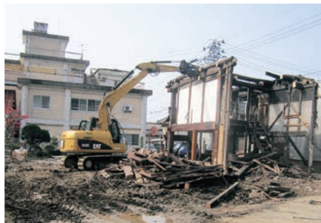
写真4-22 地震で大きな被害を受けた建物を申請に基づいて撤去 〔平成24(2012)年4月 いわき市撮影〕
