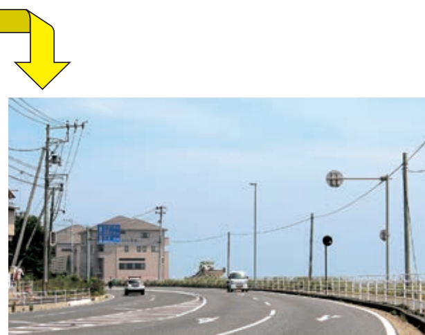
写真4-55 復旧後の国道6号〔平成24(2012)年6月 いわき市撮影〕
