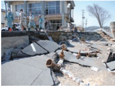
写真4-39 水道管の損傷で漏水が多発 〔市水道局撮影〕
