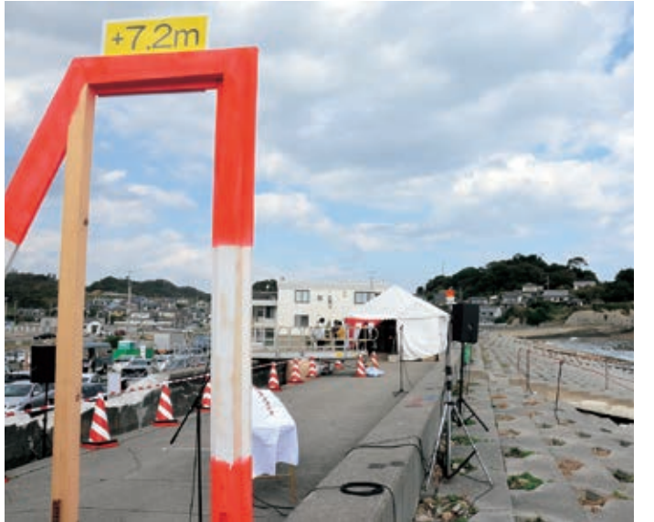
写真4-89 復旧後の高さが木枠で示された久之浜海岸の堤防 〔平成24(2012)年11月7日 いわき市撮影〕
