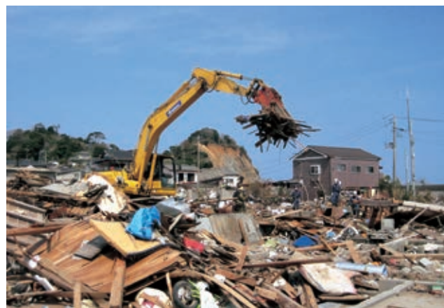
写真4-19 重機による津波ガレキの撤去作業 (久之浜町) 〔4月26日 いわき市撮影〕
