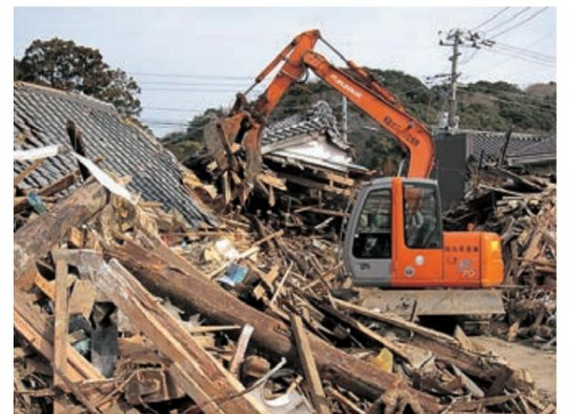
写真3-22 津波に破壊されたガレキの撤去
