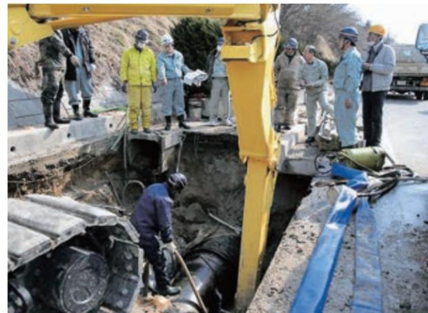
写真3-52 市外からの応援で復旧が進む上水道施設
