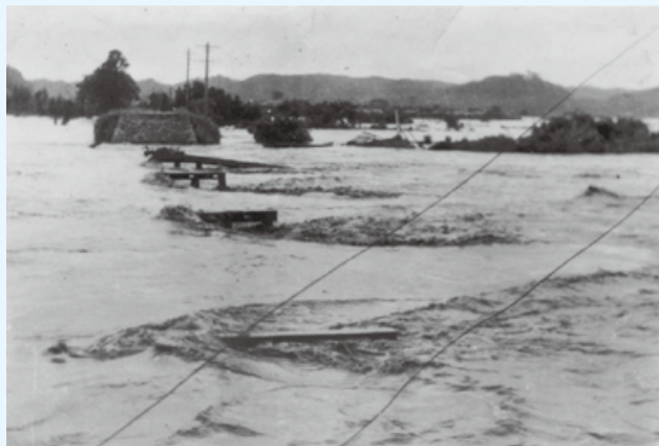
▲写真 鮫川の洪水で、河川敷を通っていた旧街道沿いの家屋が流され、木橋も流出〔昭和16（1941）年7月 渡辺徳太氏提供〕
