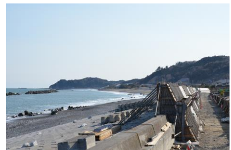
海岸堤防の整備工事（H26 年 3 月）
