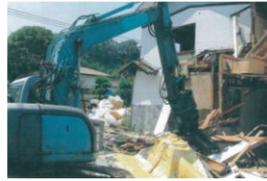
【図 2 津波被災地区残置基礎の解体撤去状況】
