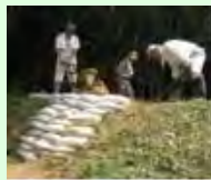
漏水箇所の補修
