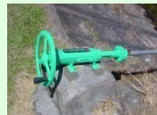
ゲート、バルブの更新
