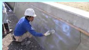
老朽化した水路壁のコーティング
