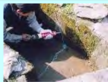
水路のひび割れ補修
