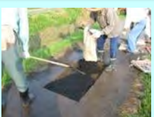
農道の部分補修
