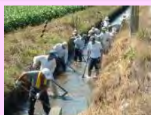
水路の泥上げ
